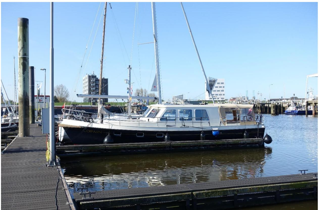
Die Schwimmstege gleiten an langen Stahlrohren. Diese sind so lang, dass sie auch bei einer Sturmflut nicht versagen.
