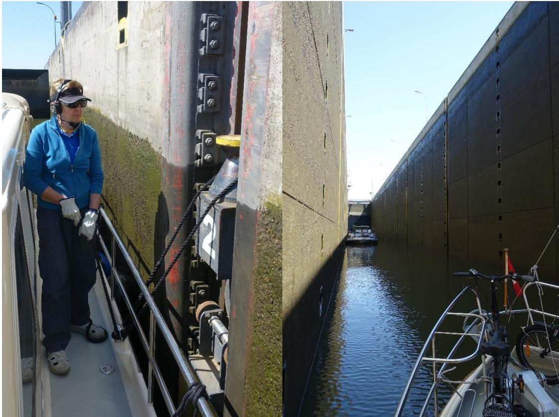
Obwohl das Wasser sehr schnell aus der Kammer fliesst, gleiten wir mit dem Schwimmpoller ganz ruhig und sicher 19 Meter zu Tal.
