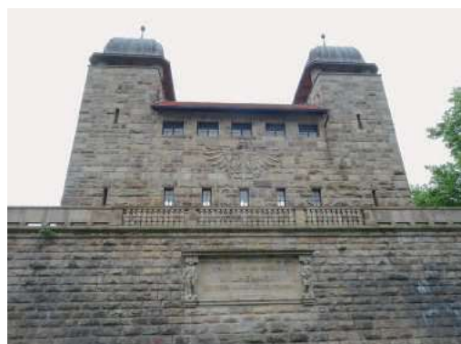
Die Schachtschleuse von 1914
